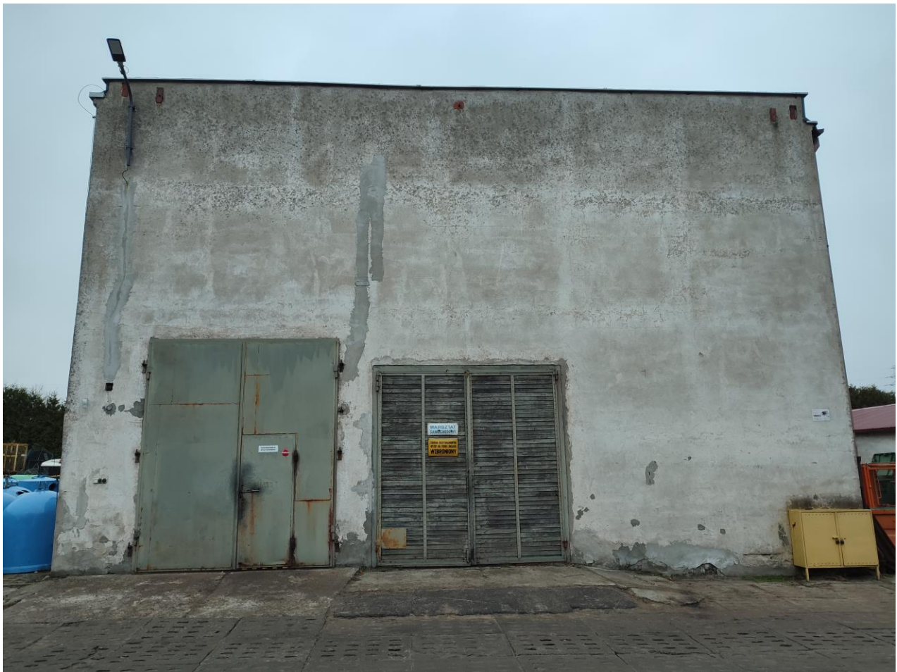
Elewacja południowa , bramy do wymiany.
